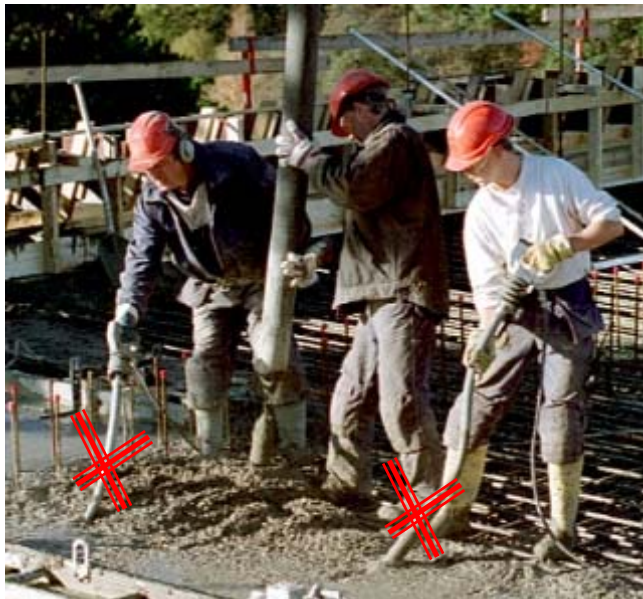
Vibrering behövs inte om man använder självkompakterande betong
